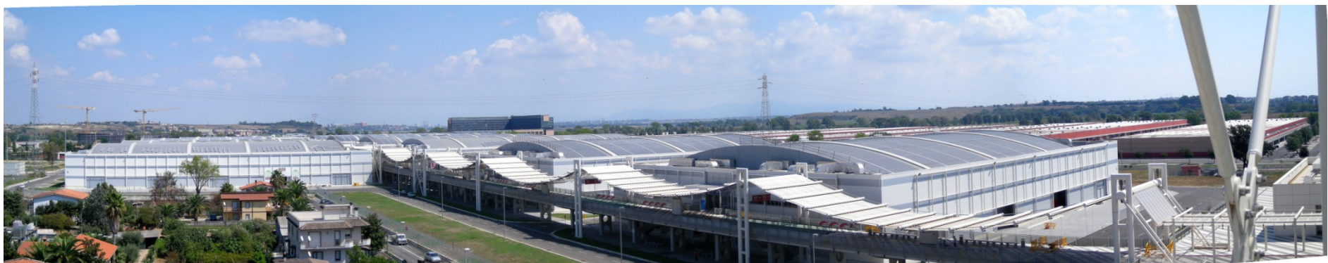
1,5 Mwp of Thin Film copertura padiglioni della Nuova Fiera di Roma
